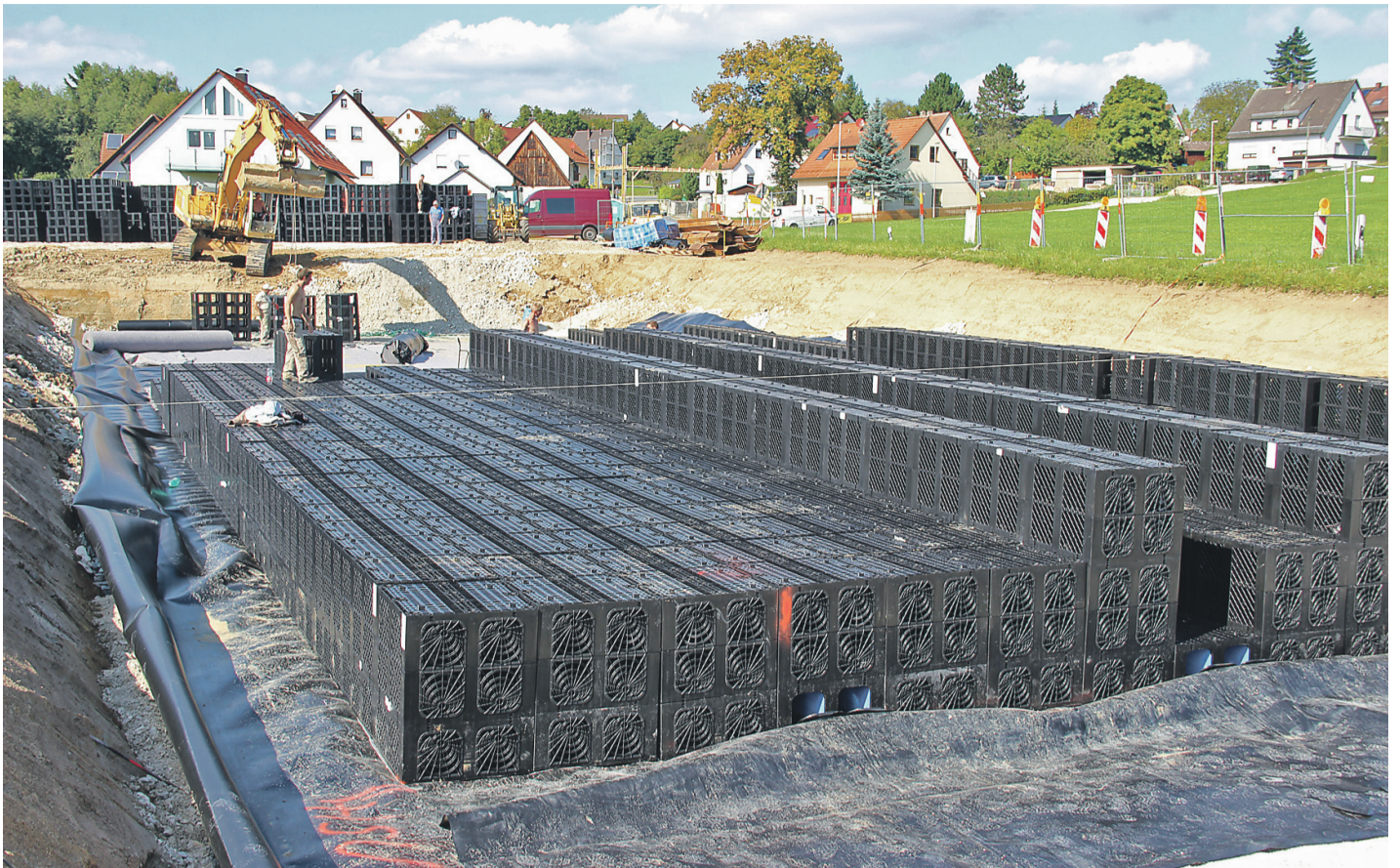
Schwarze Kunststoffelemente stabilisieren das Germersberger Regenrückhaltebecken, dessen Ränder künftig aus Teichfolie bestehen und das komplett mit Erde verfüllt wird. Foto: Schuster
